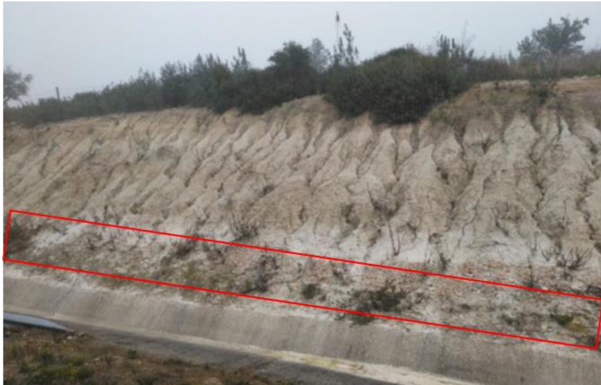
Figura 3.2 - Talude em campo.
